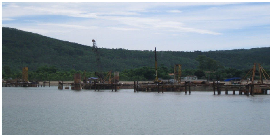
Hình 3.1. Cầu Văn Hóa vượt sông Gianh đang được xây dựng
