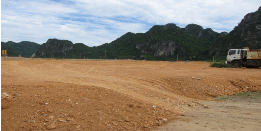
Hình 2.3. Mặt bằng Nhà máy Xi măng Văn Hóa đang thi công
