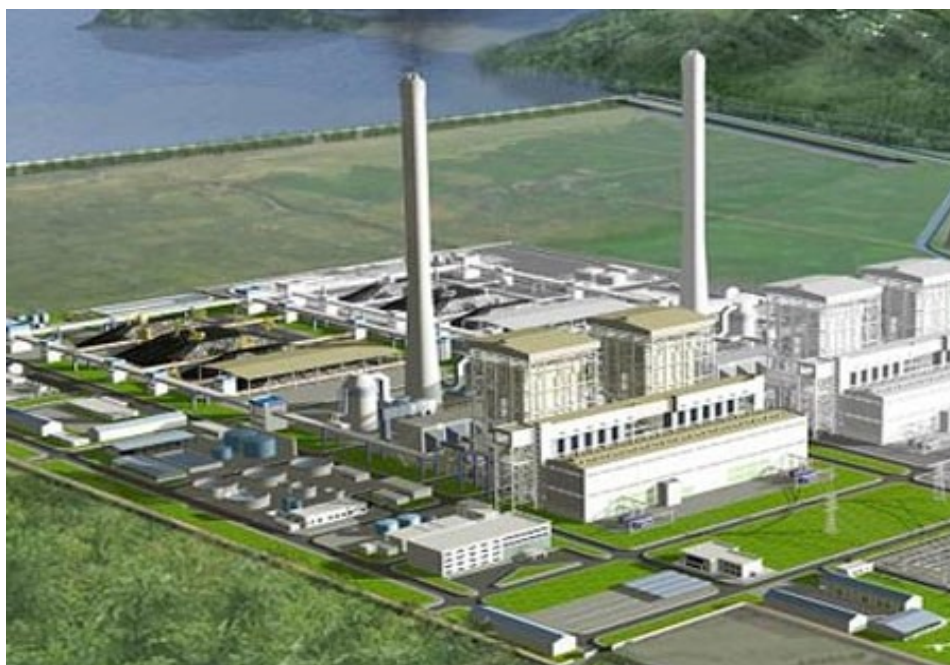
Hình 2.2: Nhà máy nhiệt điện Quảng Trạch 1
