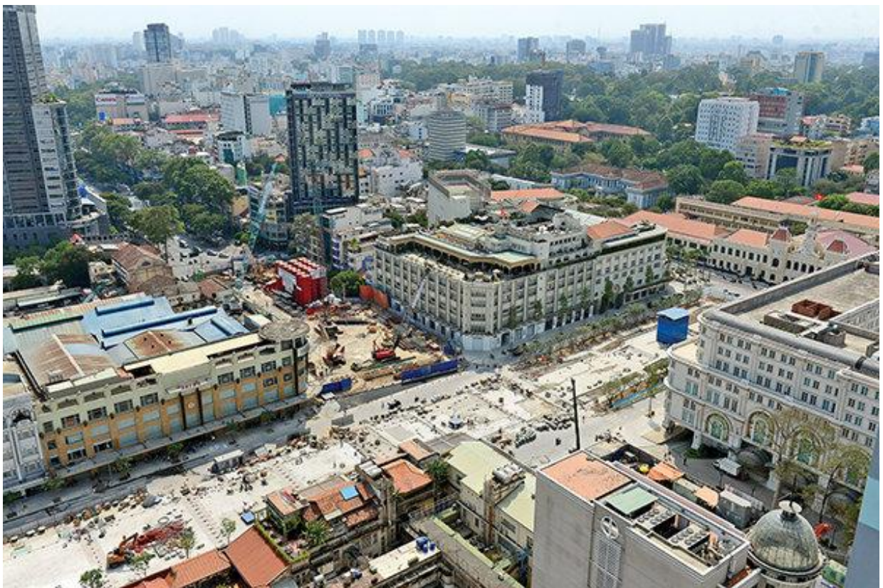
Nhà ga cho hệ thống tàu điện ngầm đang được xây dựng ở TP.HCM
