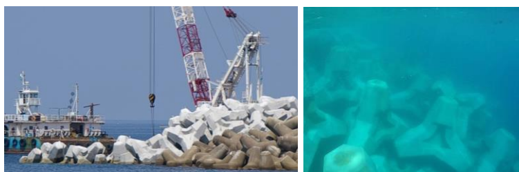
Hình 1.15 Thi công lắp đặt các khối phủ RAKUNA-IV ở đoạn đầu đê [6]
