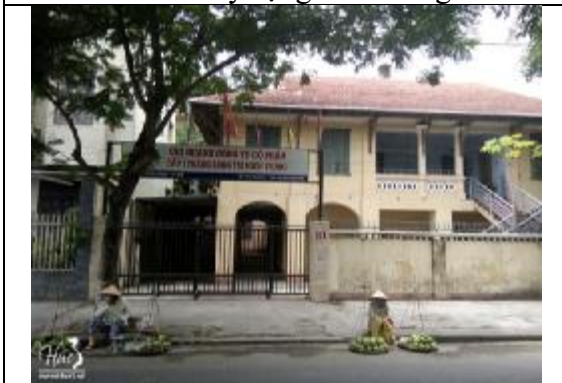
Công ty Cầu 01 Thăng Long
