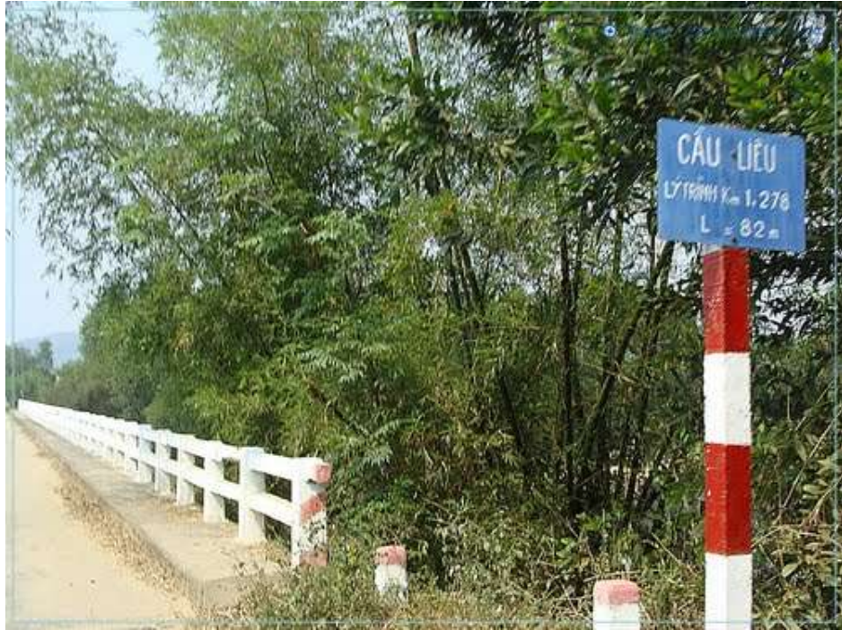
Hình 3.2. Công trình cầu Liêu - huyện Thạch Thất.
