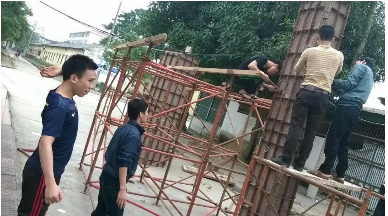
Lắp dựng cốt pha sàn và ván khuôn cột
