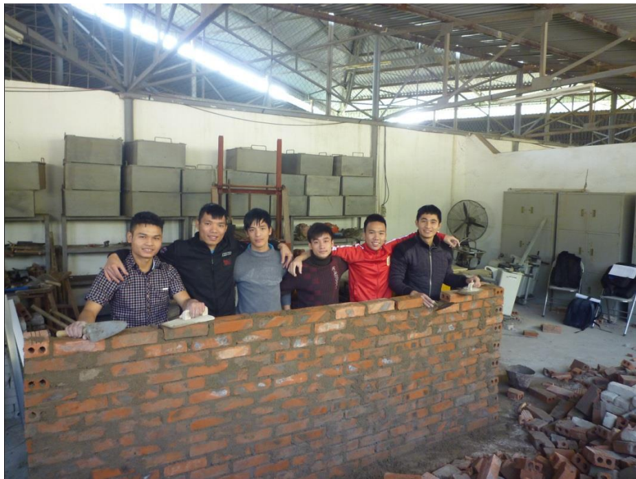
Kỹ thuật xây tường gạch chỉ dày 110 bổ trụ liền tường
