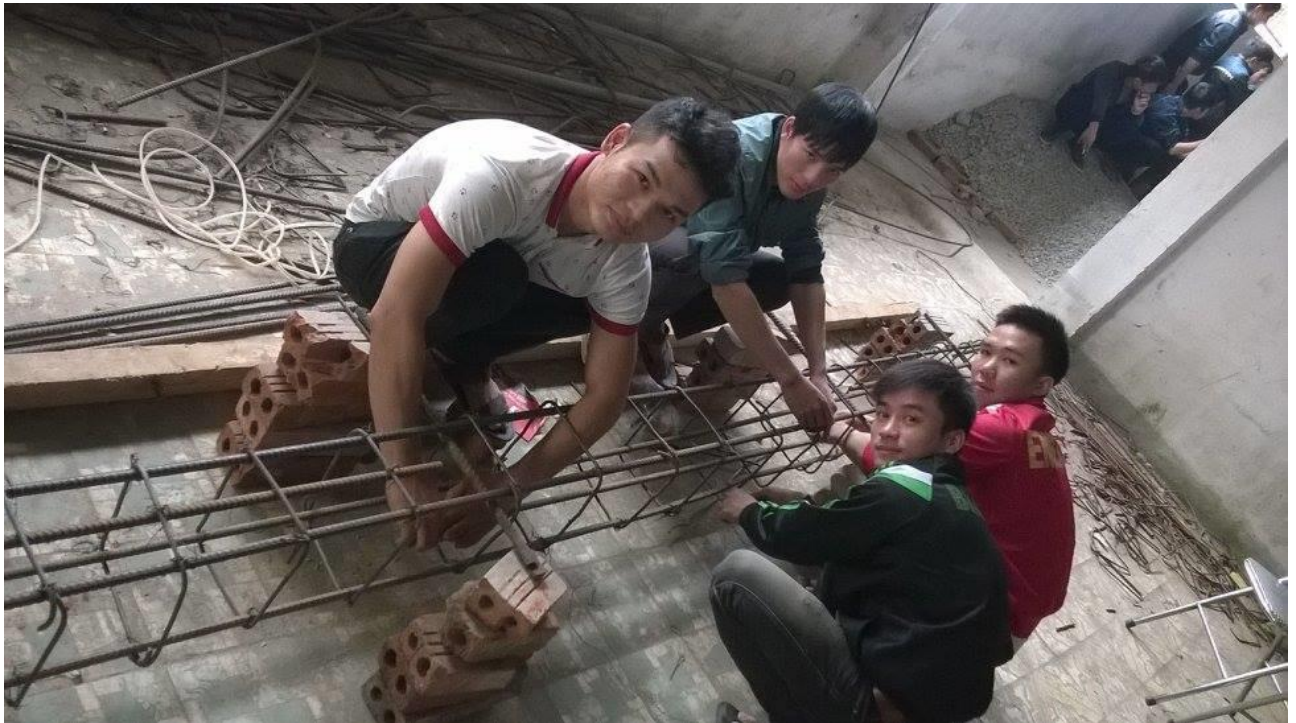
Nối buộc cốt thép dầm
