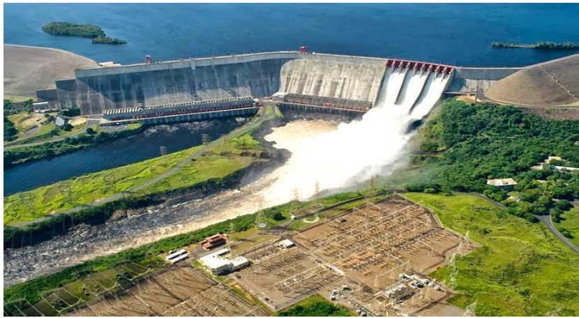
Hình 1.3 Công trình thủy điện Guri
