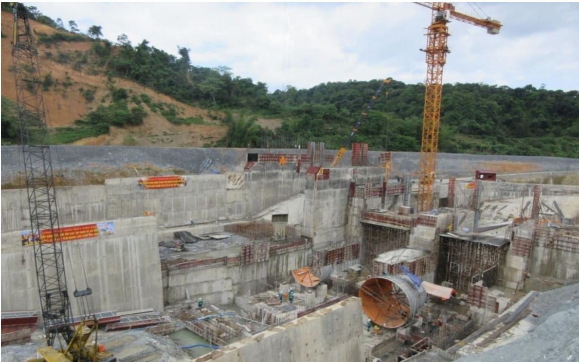
Hình 3.5 Bê tông nhà máy và trụ pin cửa nhận nước
